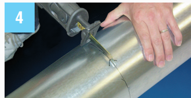
4 Taladre un orificio de acceso y luego corte el tubo con una sierra.
