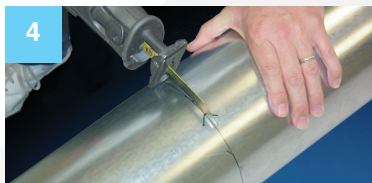
Taladre un orificio de acceso y luego corte el tubo con una sierra.
