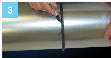
3 Use la junta tórica provista y márkela para cortar.
